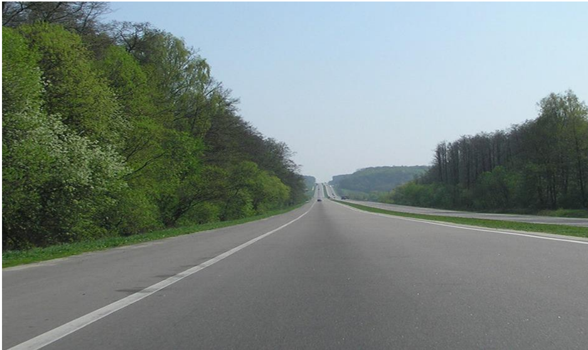
Foto 14: Autobahn S-11, renoviert mit Hilfe der EU-Finanzierung (eigene Aufnahme 02.09.2015)
