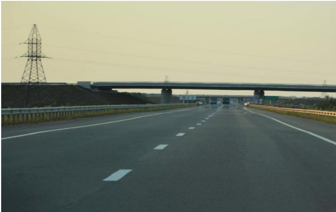
Foto 11: Autobahn M-6, renoviert im Rahmen des Projekts „Nord-Süd-Straßenverbindung Armenien“ (eigene Aufnahme 09.08.2015)
