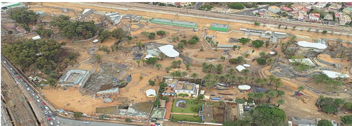
Chantier du parc zoologique d'Ain Sebâa
