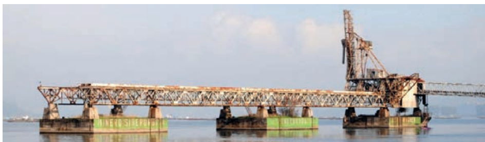
Figura 5. Cargadero de Coto Wagner (Redondela)
