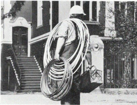
Für die Wasser- und Heizungsinstallation sind Kupferrohre auf vielfache Weise wirtschaftlich: Kupferrohre transportieren schneller. Die Strömung in ihren glatten Wandungen ist reibungsarm. Wegen der höheren Durchflußleistung können ihre Dimensionen vergleichsweise geringer sein. Man spart Material und Platz. Und bei Heiz- und Warmwasseranlagen schränken strömungsfähig kunststoffummantelte Kupferrohre Wärmeverluste wirksam ein.
