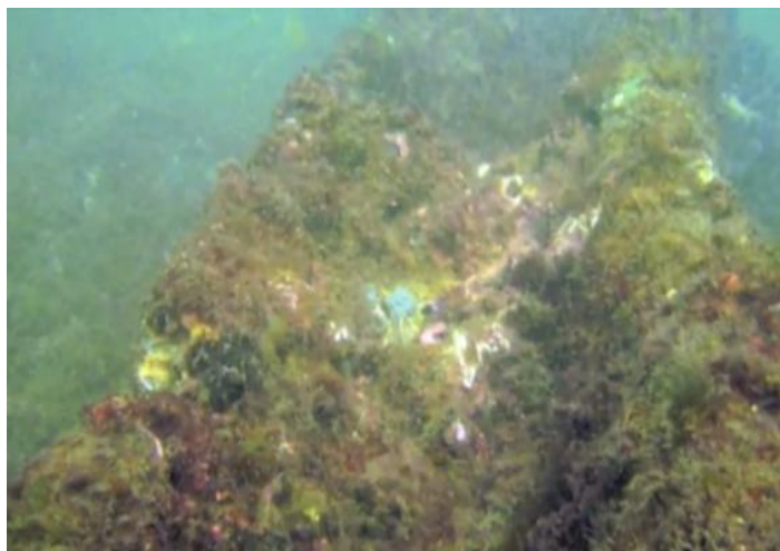
Figura 5. Foto de muro submarino de 2009.
